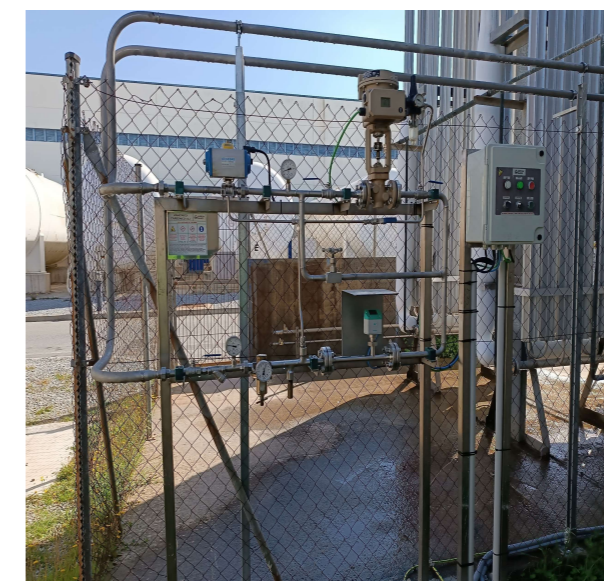
Fotografia 13. Accessoris del sistema de diòxid de carboni.
