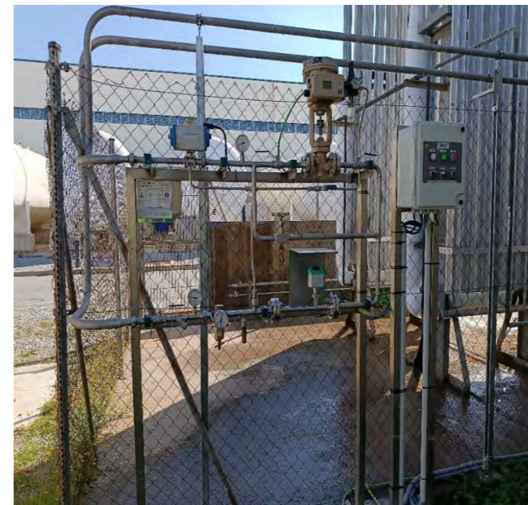
Fotografia 12. Accessoris del sistema de diòxid de carboni.
