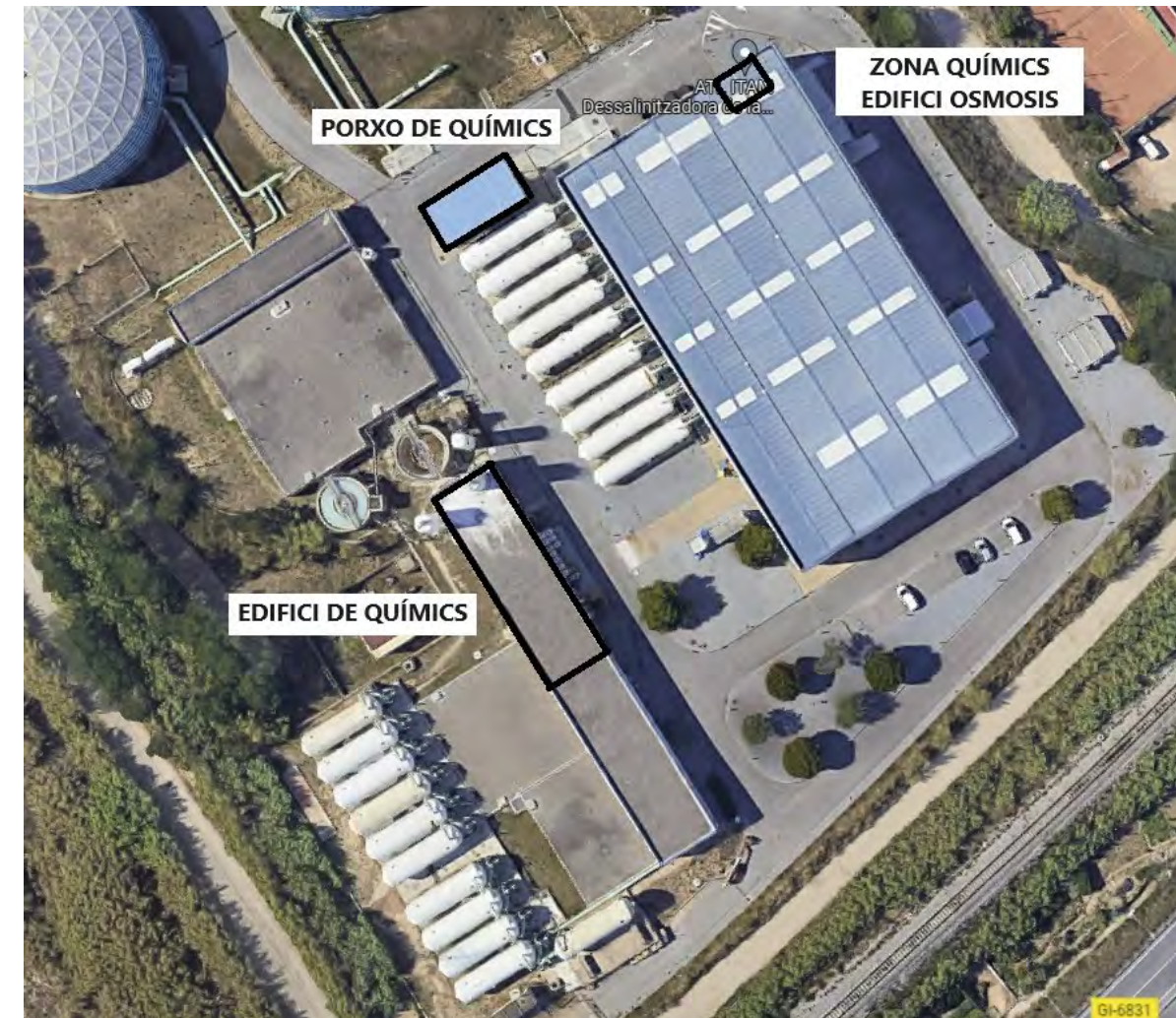
Fotografia 1. Emplaçament dels equips a renovar
