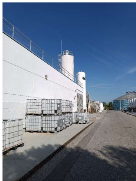
Fotografia 17. Zona exterior edifici a rehabilitar
