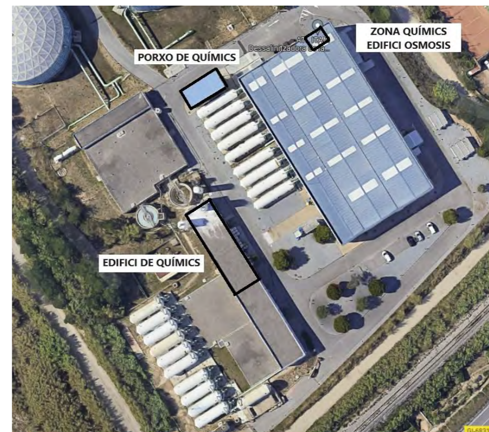
Fotografia 1. Emplaçament dels equips a renovar
