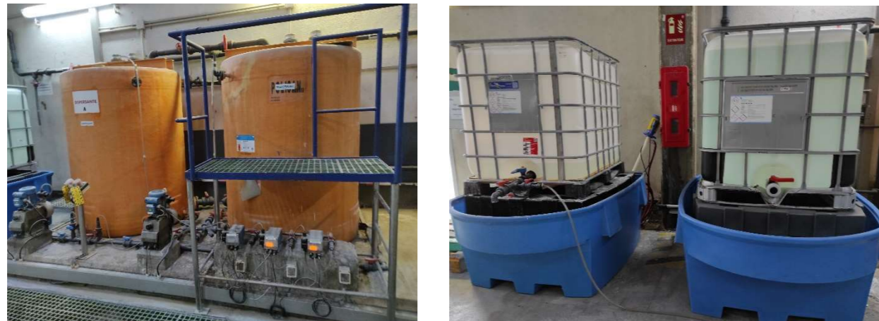
Fotografia 7. Dipòsits de dispersant 1er pas i Fotografia 8. GRGs de dispersant 1er pas.
