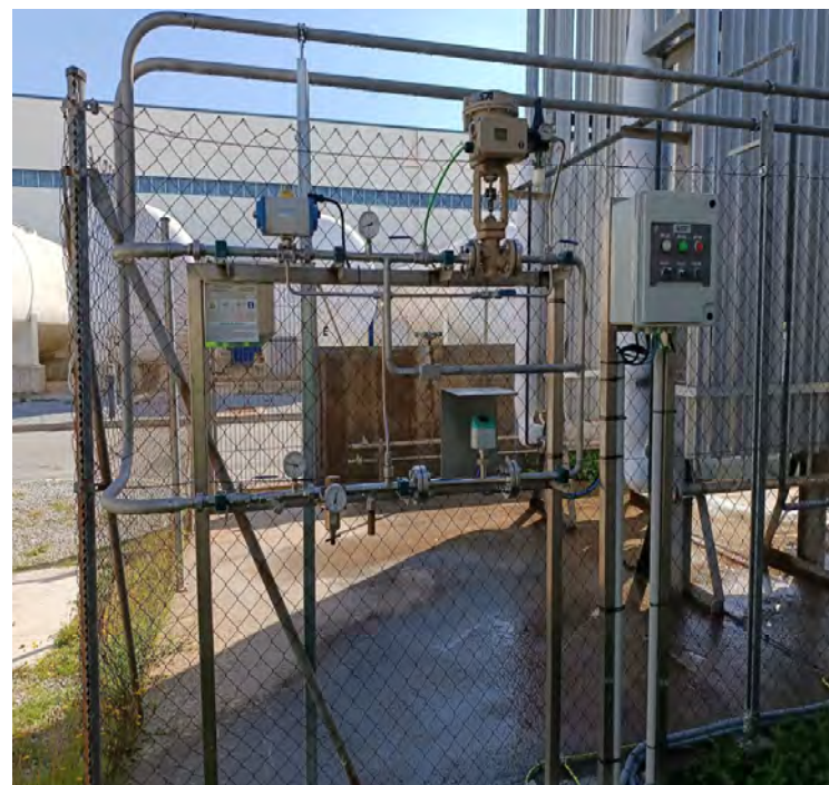
Fotografia 13. Accessoris del sistema de diòxid de carboni.
