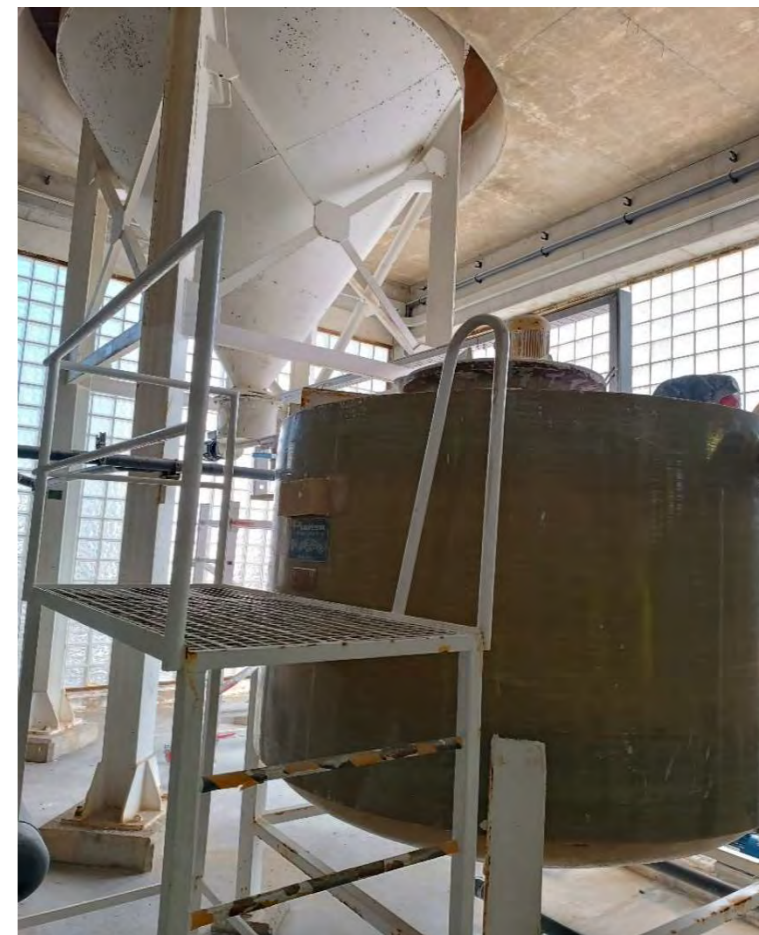
Fotografia 10. Sitja i saturador de calç per a la lletada d'hidròxid càlcic.
