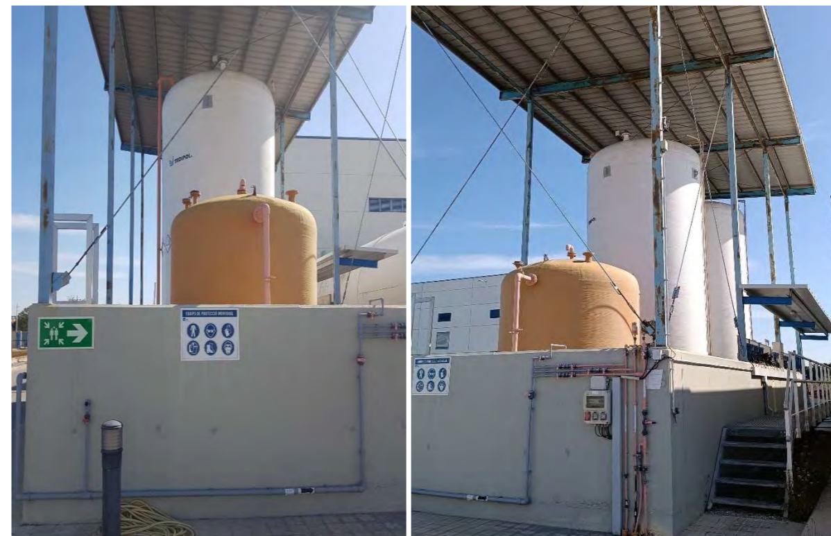
Fotografia 13. Dipòsits de hipoclorit sòdic en primer pla i hidròxid sòdic al fons.
