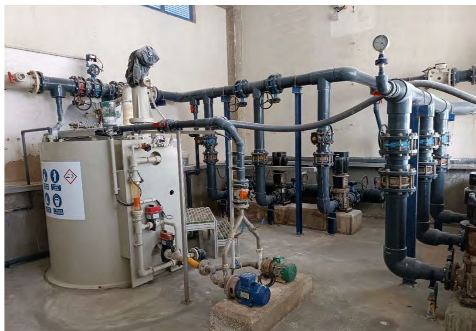
Fotografia 9. Cuba de preparació per a la lletada d'hidròxid càlcic.
