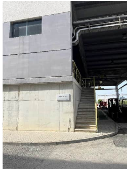
Foto 22. Façana Est amb detall de l'escala d'accés al pis superior, començant arran de la línia de façana.
