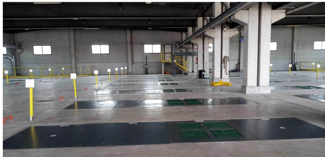
Foto 1. Vista general de la nau de remineralització. En primer pla, les quatre tapes que cobreixen un dels llits
