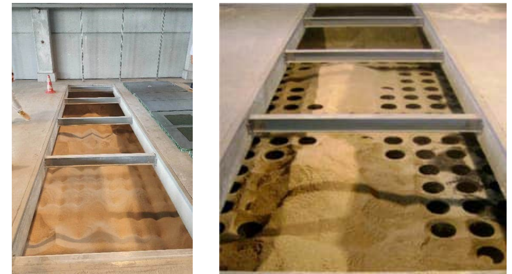
Foto 7. A l'esquerra, llit ple de calcita. A la dreta la calcita s'ha anat consumint, deixant a la vista els conus dosificadors.
