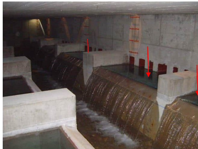
Foto 3. Punts de presa de mostra per a la mesura de la terbolesa, en els canals de sortida individual de cada llit, (Font. Drintec)
