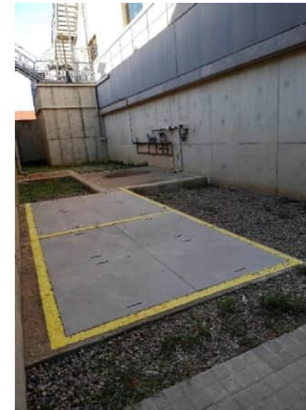
Foto 12. Arquetes de la canonada d'entrada a remineralització
