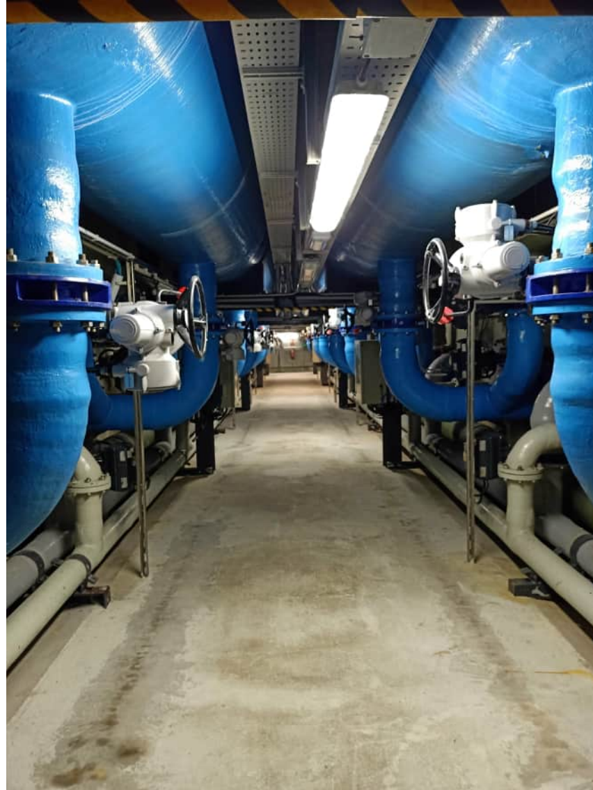
Foto 5. Safates de PVC (Elèctriques i de Comunicacions) en la planta inferior de l'edifici de Llits de calcita.
