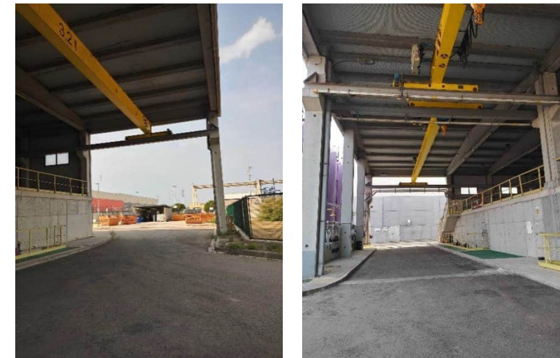
Foto 9. Nau de remineralització. Vial de descàrrega. Façanes Nord, Oest i Est.
