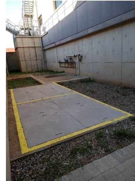
Foto 1. Arquetes de la canonada d'entrada a remineralització
