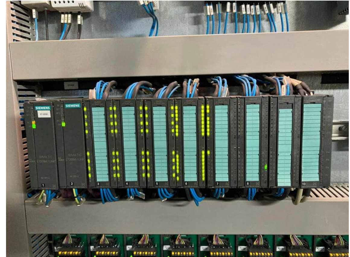
Foto 2. Ocupació de la remota existent en l'armari 07 PLC 6A01 (Línia A, Llits Calcita 1-16).
