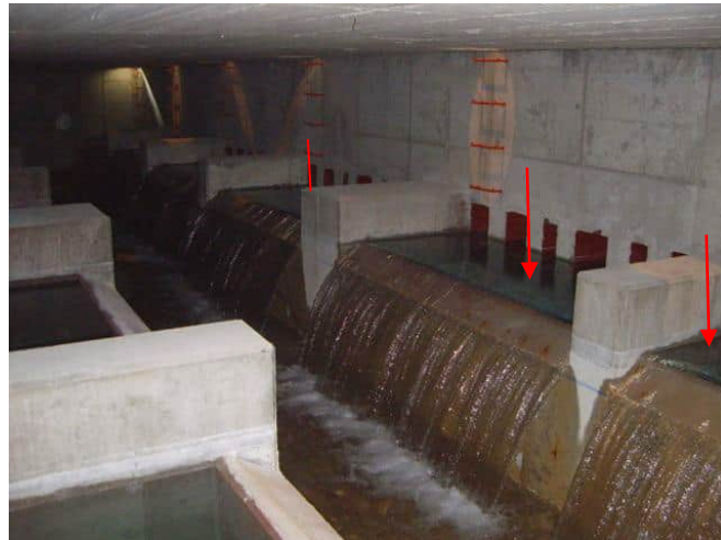
Foto 4. Punts de presa de mostra per a la mesura de la terbolesa, en els canals de sortida individual de cada llit, (Font. Drintec)
