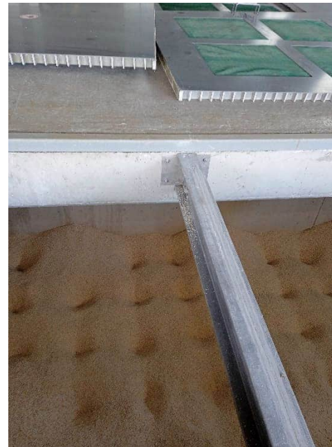
Foto 5. Detall de l'ancoratge del perfil transversal al mur de la sitja
