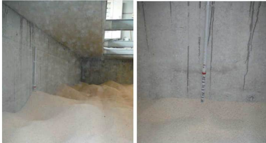
Foto 8. Escala graduada adossada a la paret per a la lectura del nivell de calcita.
