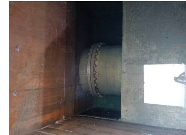
Foto 1. Arquetes de la canonada d'entrada a remineralització
